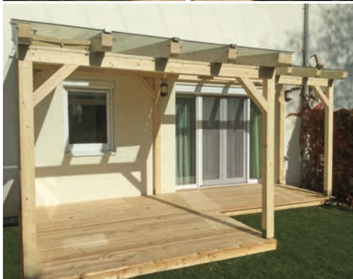
^ Pergolaüberdachung mit Terrassendielen aus sib. Lärche
