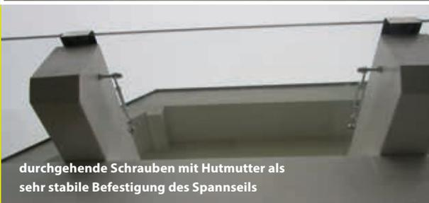
durchgehende Schrauben mit Hutmutter als sehr stabile Befestigung des Spannseils
