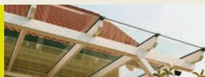
Um den konstruktiven Holzschutz der Balken zu gewährleisten empfehlen wir, neben einem deckenden Erstanstrich, eine umlaufende Blechverwahrung und Dachrinne anzubringen.
