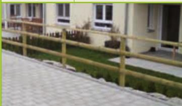
Pfähle KDI\* zylindrisch gefräst, Kopfende gefast
